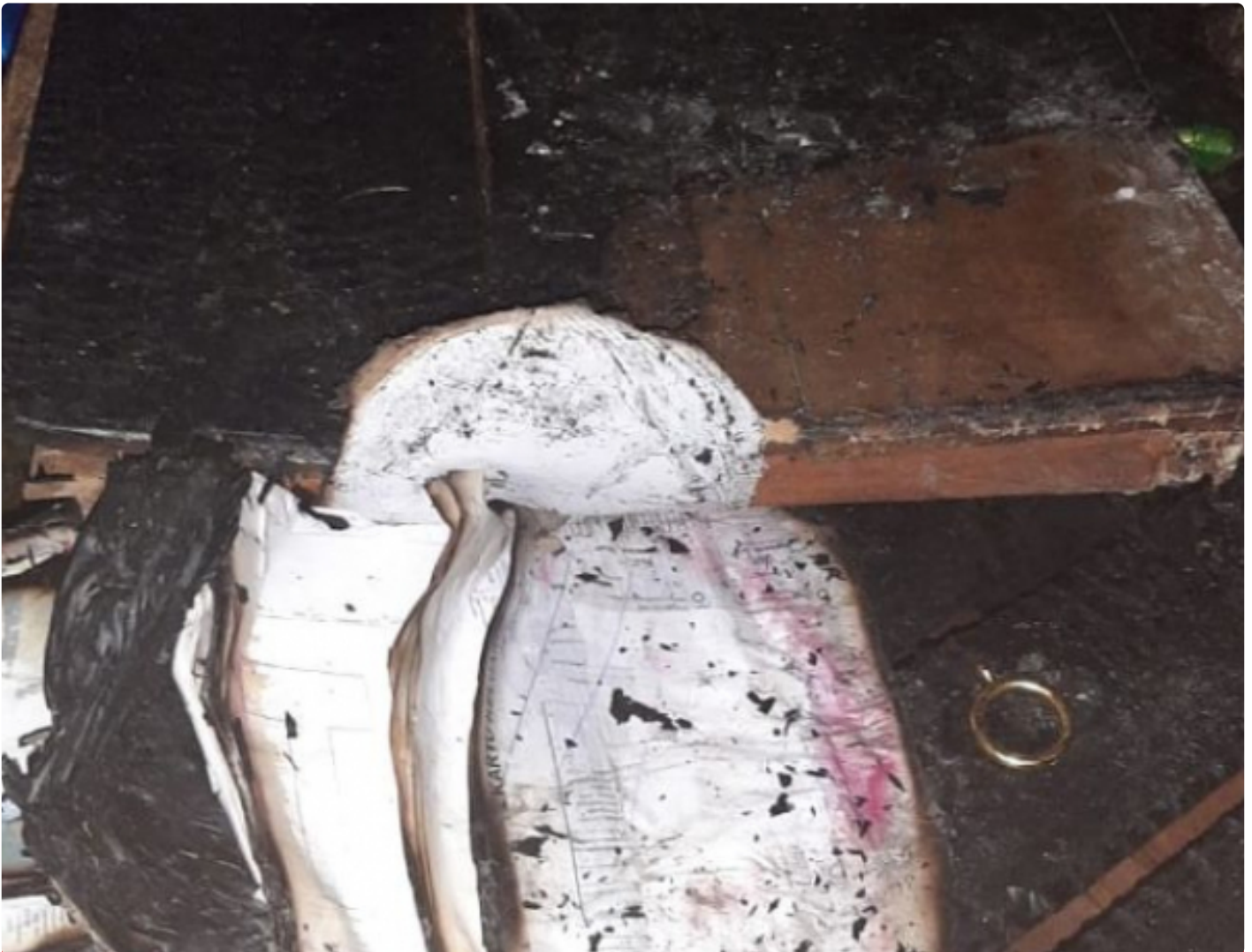
Kondisi terkini Kantor Desa Wolowea pasca kebakaran
